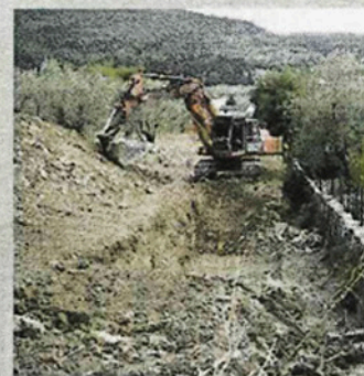
Lavori nella zona di Ascoli
